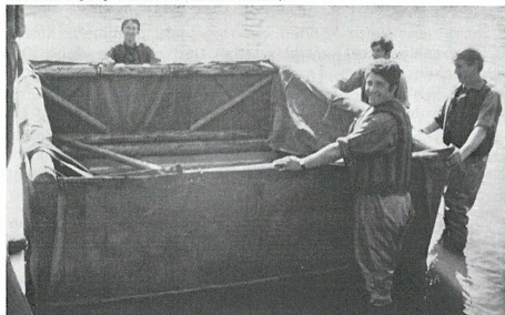
Abb. 9: Die eingeschlagene LKW-Plane dichtet bei sorgfältiger Spannung und Befestigung am Seitenrahmen (unten).
