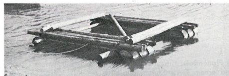
Abb. 3: Rundholzrahmen auf 200-l-Ölfässern aufgesetzt.
