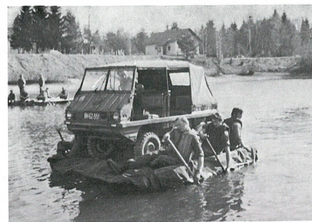
Abb. 14: Für das Übersetzen von Klein-Kfz wird der Deckrahmen des Planenfloßes mit zusätzlichen Rundhölzern oder Brettern als Spuraufgabe verstärkt.
