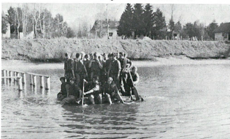
Abb. 13: Das Planenfloß beim Ablegen von der Übersetzstelle.
