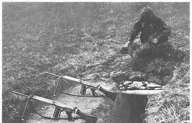
Zweimannkampfdeckung mit Unterschlupf — groß; Einbau der Tarnschicht.
