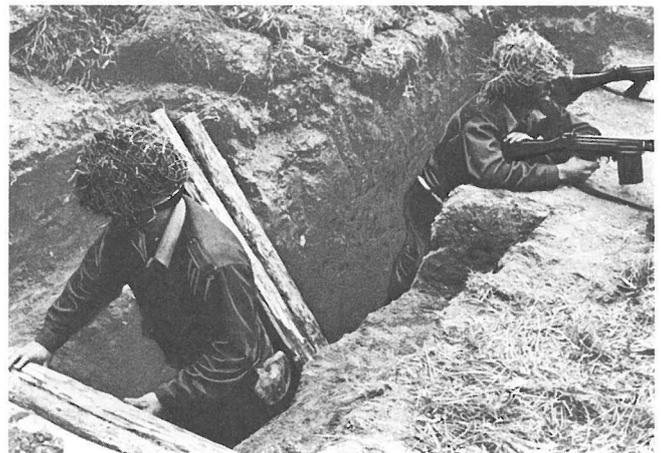
Zweimannkampfdeckung mit Unterschlupf — groß; Einbau der Holzeindeckung aus 10 bis 15 cm starkem Rundholz.
