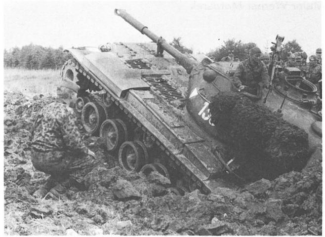
Sperrversuch mit Trichtersperrung. Im mittleren Boden entsteht dabei ein Sprengtrichter bis zu drei Meter Tiefe und zehn Meter Breite. Aneinandergereiht ergeben Trichtersperrungen einen durchgehenden Panzergraben.
