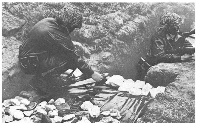
Einbau der Zerschellschicht über Rundholzschiene und wasserdichter Abdeckung mit Plastikfolie.
