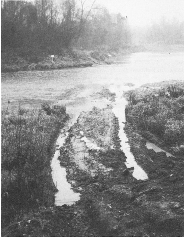
Schluffiger Uferbereich bildet für die Furtung durch Panzerfahrzeuge bei Niederwasser bereits Schwierigkeiten (Aufsitzen der Wanne, Durchdrehen der Ketten).
