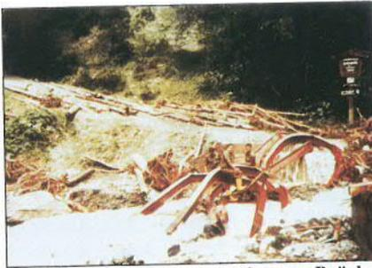
Das Tragwerk einer weggerissenen Brücke muß aus dem Bachbett entfernt werden.
