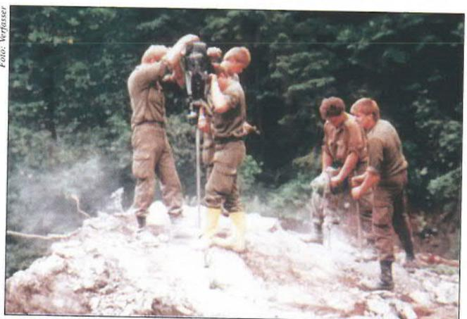
Zum Öffnen der Verkläusung muß ein in das Bachbett gestürzter Fels gesprengt werden. Pioniere beim Herstellen der Bohrlöcher für die Sprengladungen.
