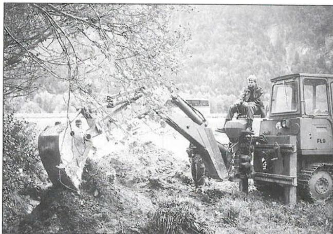
Sollen die für den feldmäßigen Stellungsbau erforderlichen Zeiten in einigermaßen erträglichen Grenzen bleiben, ist die Unterstützung mit mindestens einer Baumaschine pro Zug unerlässlich (im Bild: Laderaube FL9 mit einem Tieflöffel als Anbaugerät).
