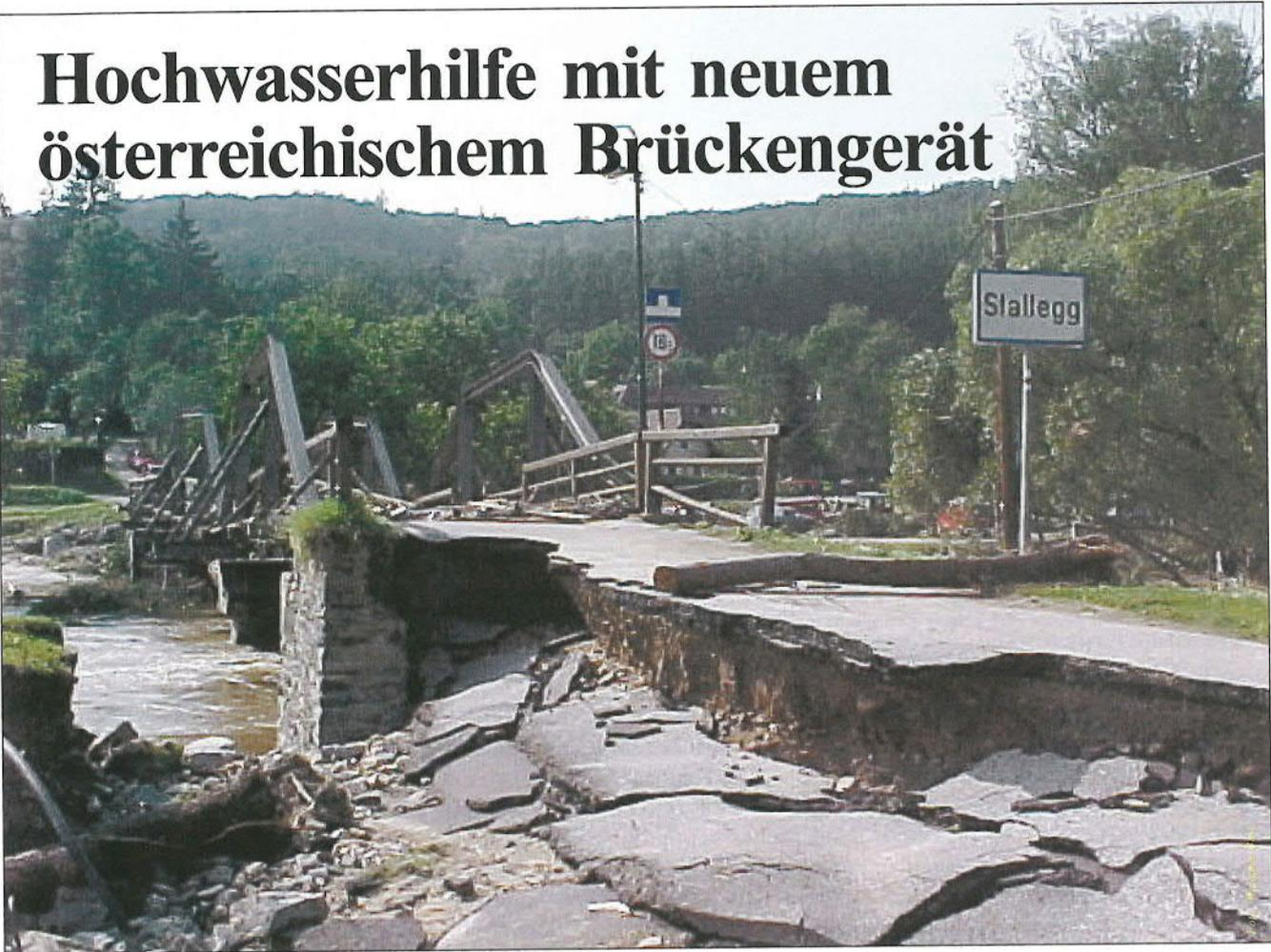
**Ihr erster Einsatz in Österreich: Hochwassermassen hatten im August 2002 die Kampbrücke in Rosenberg zerstört. Der Ortsteil Stallegg war dadurch für Fahrzeuge von der Außenwelt abgeschnitten. Die Villacher Pioniere ermöglichten mit der „Waagner-Biro Panel Bridge“ die Wiederherstellung der zerstörten Brücke. Stallegg war nach kurzer Zeit wieder mit Fahrzeugen erreichbar und die Hilfsmannschaften konnten ihre Arbeit aufnehmen.**
