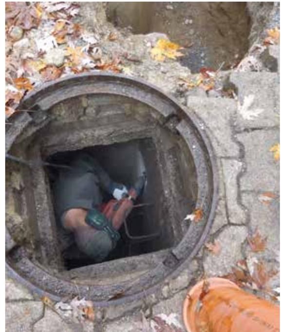
Die Anschlüsse an das öffentliche Kanalnetz werden fertiggestellt
