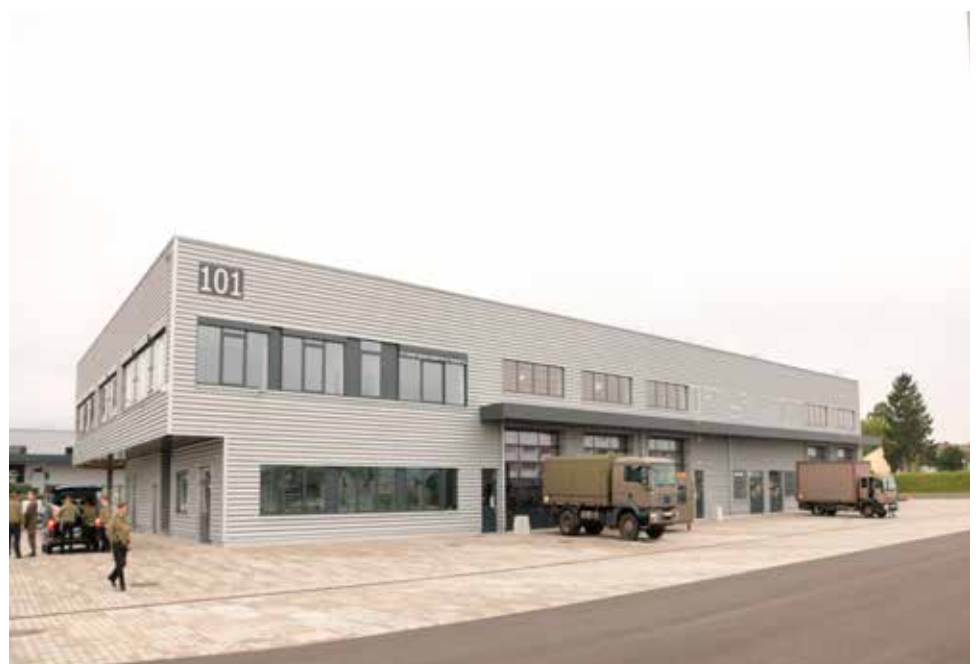
Objekt 101 im Werkstätten- und Garagenbezirk
