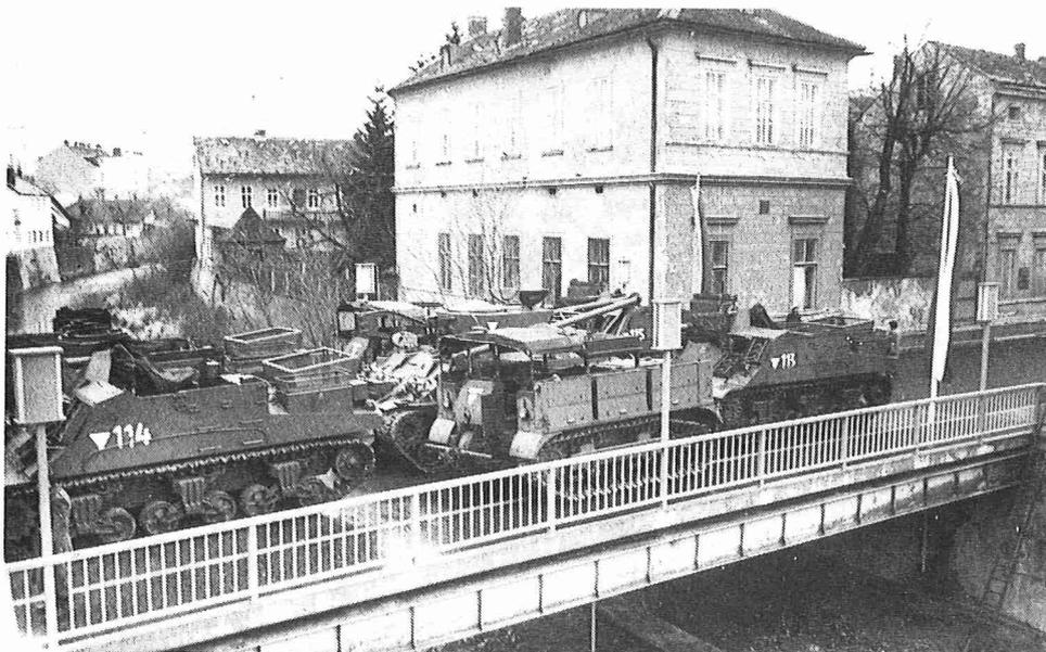
Eine andere Art von Belastungsprobe: 4 M7B2, ein Bergepanzer, sowie zwei schwere Zugmaschinen auf der neu errichteten Olympiabücke im Jänner 1966
