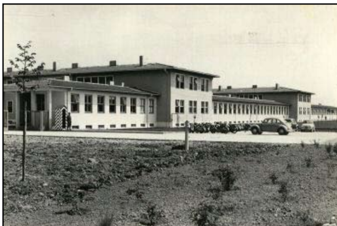
Die neuen Unterkünfte in der Raabkaserne Mautern
