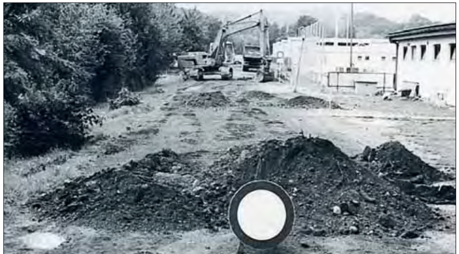
Die Skudierallee bei Baubeginn im September 1999...
