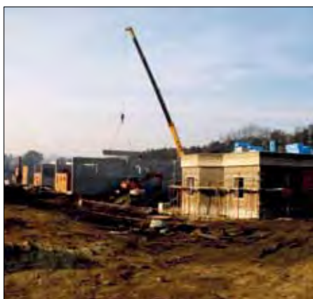
Um den neuen Mannschaftstransportpanzern Pandur ein Dach über den Kopf zu geben, wurde bereits 1997 begonnen, deren „Unterkünfte“ samt einer Tankstellenanlage und einem Wachgebäude zu errichten
