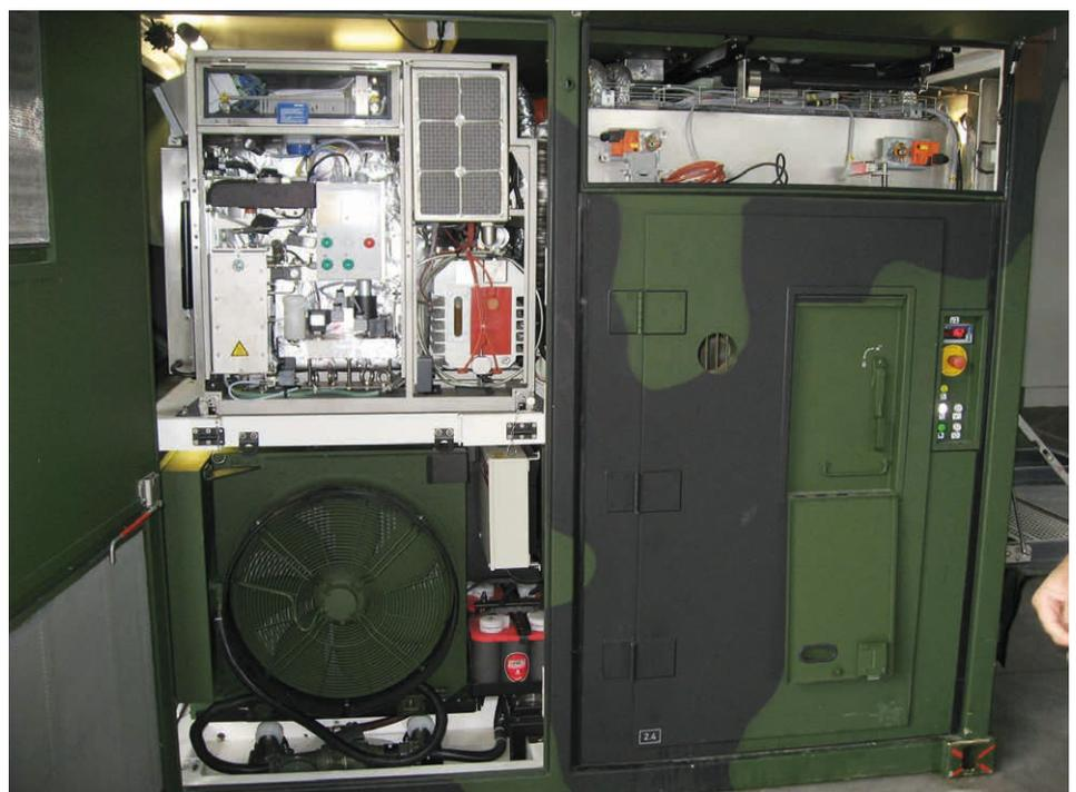
Abb. 6: Das B-Modul – links unten der 30 kVA Stromerzeuger. (Foto: Hämmerle)
