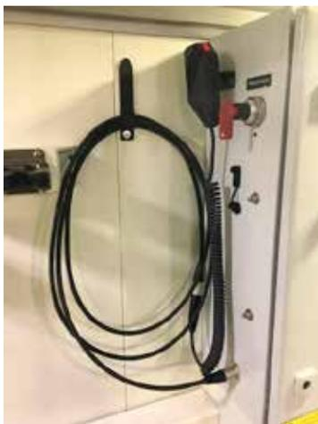
Schaltkasten inkl. Integration einer Gegensprechanlage mit Handapparat
