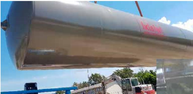
Isolationsprüfung des Lagerbehälters am Kranhaken
