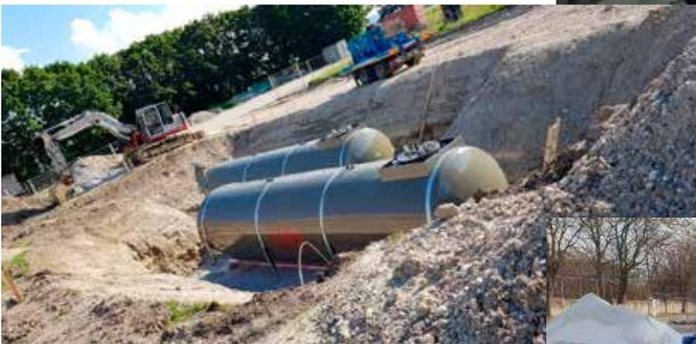
Einsenkung der Lagerbehälter und Befestigung auf Grundplatte für die Kfz-Tankanlage Langenlebern
