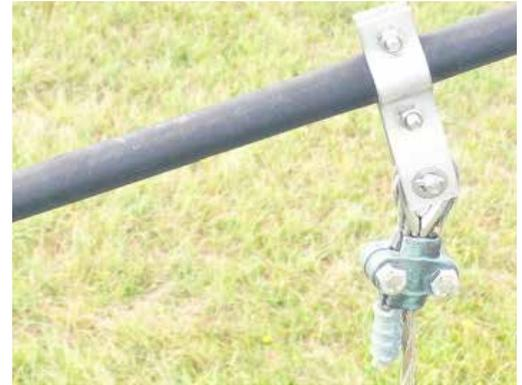
Abbildung 6: Tragseil mit Antennenschelle
