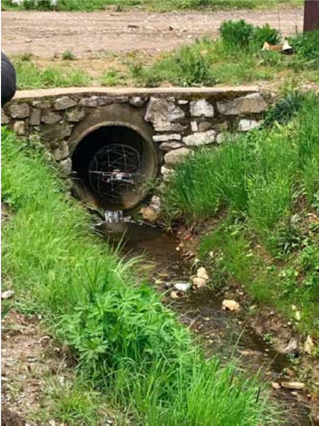
Abb 5: Käfigdrohne inspiziert ein Kanalrohr
