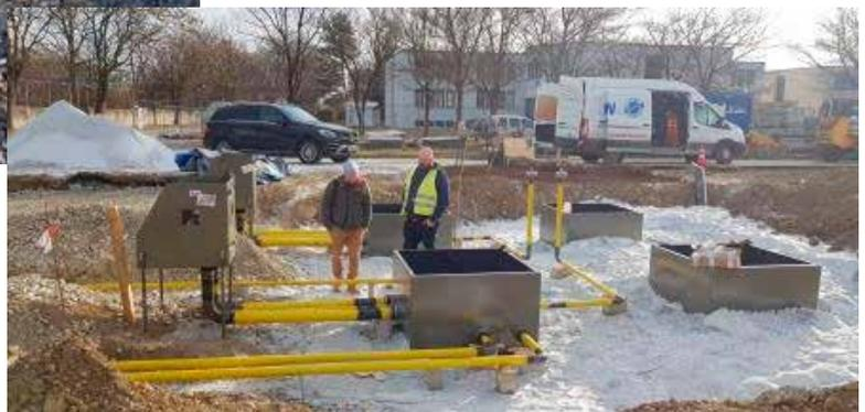
Isolationsprüfung der Rohrleitungen der Kfz-Tankanlage Graz
