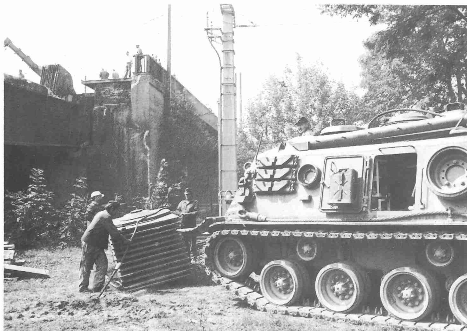
Bergepanzer M-88 bei Aufräumarbeiten an der eingestürzten Reichsbrücke 1976.
