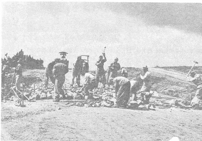
Beim Straßenbau am TÜPl ALLENTSTEIG
