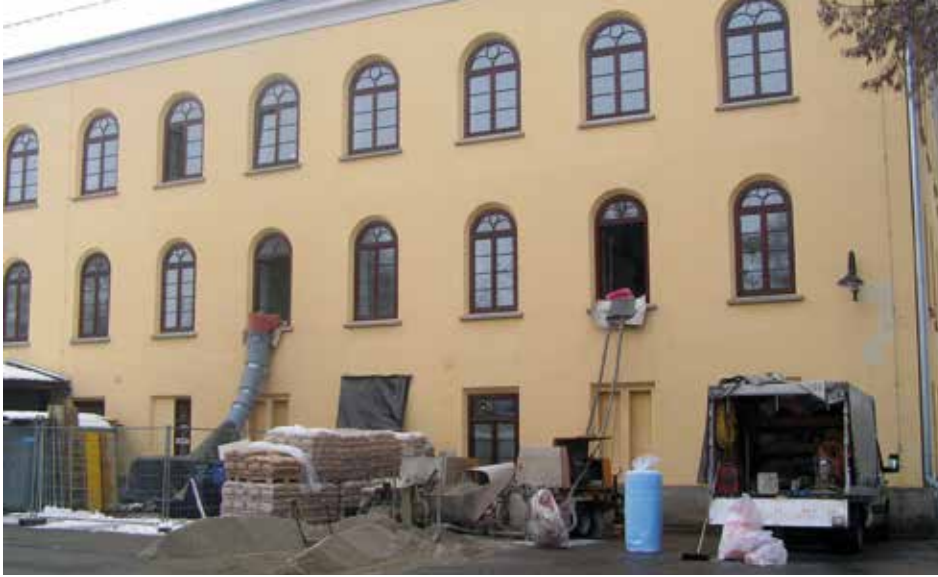
Renovierungsarbeiten im Schloss der Erzherzog Johann Kaserne.
