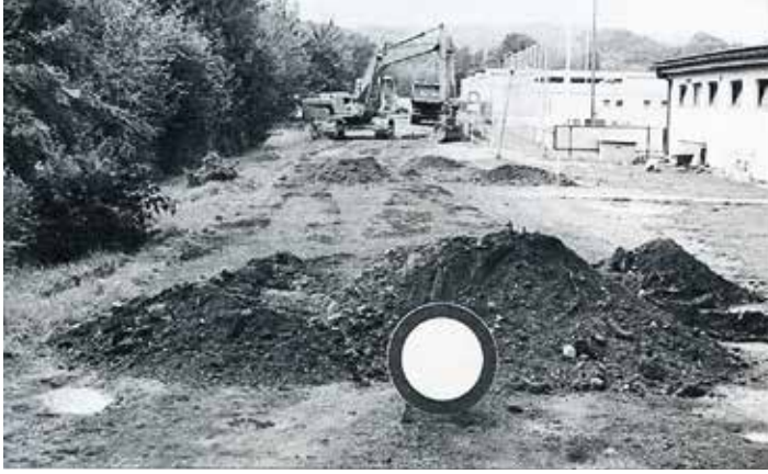
Die Skudierallee bei Baubeginn im September 1999...
