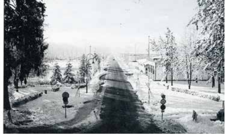
...und nach Fertigstellung im Dezember.
