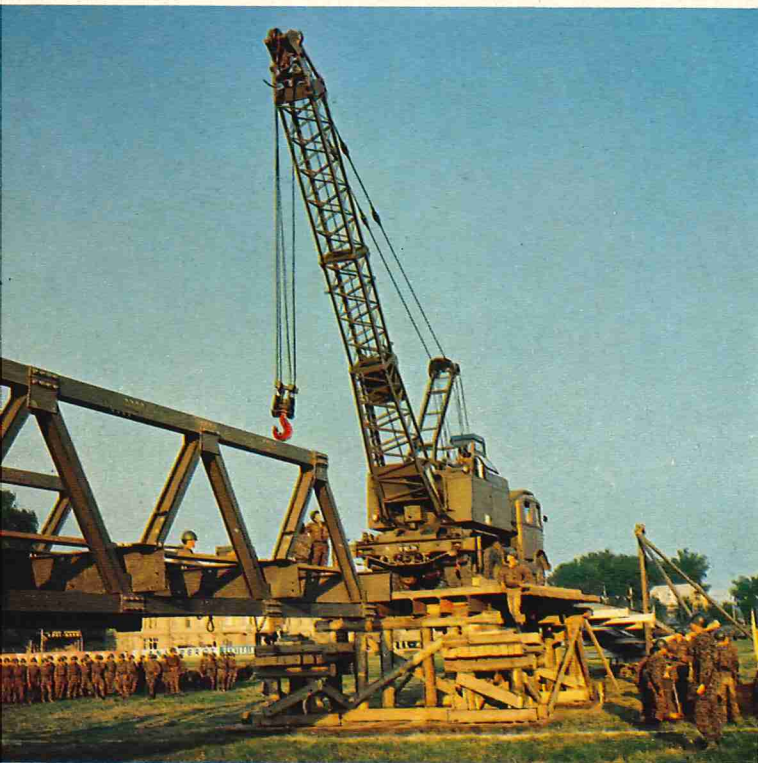
Spielend leicht bringt der Auto- kran die Bauteile einer D-Brücke in richtige Position – wenn er vom richtigen Mann bedient wird. Der voPD-Pionier ist schon nach kurzer Dienstzeit in wich- tigen Funktionen tätig (oben)
