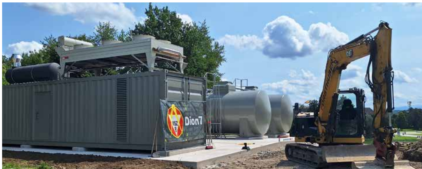
Neues Notstromaggregat der Marke MTU (Motoren, Turbinen Union)
