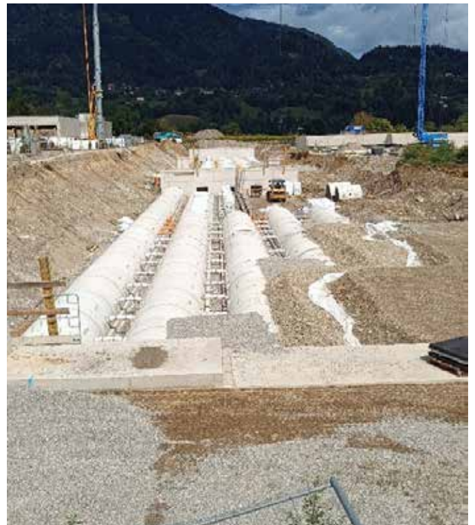
Sickeranlage im Werkstätten- und Garagenbezirk
