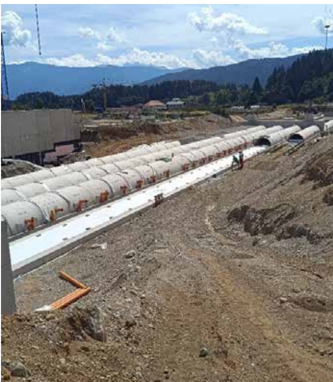
Sickeranlage im Werkstätten- und Garagenbezirk
