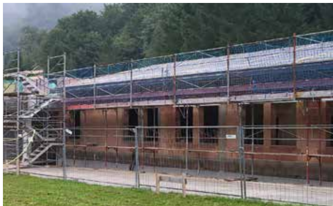
Rohbau Büro und Wirtschaftstrakt
