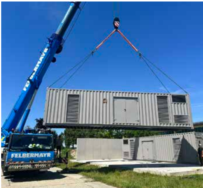
Positionierung der Notstromaggregate
