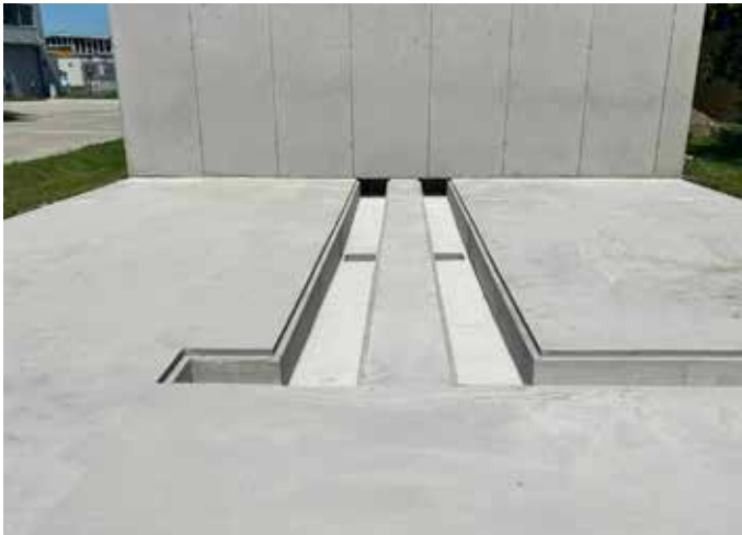
Bodenplatten für zwei Container
