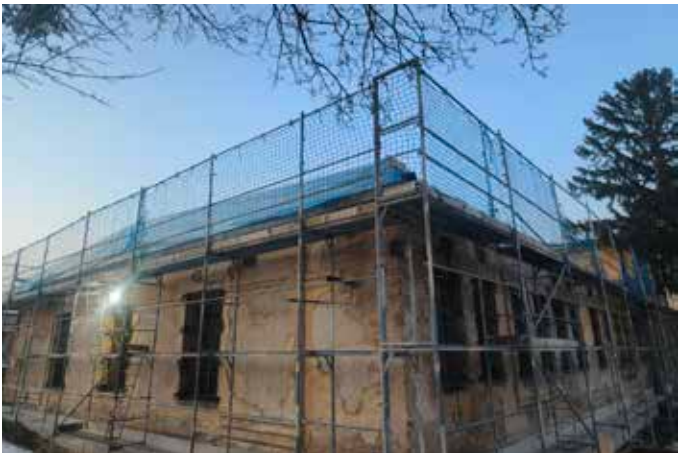
Fassadengerüst am Bestandsgebäude während der Sanierungsarbeiten
