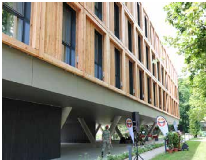
Vorderansicht der Holzmodulbauweise des Wohnheims Wiener Neustadt
