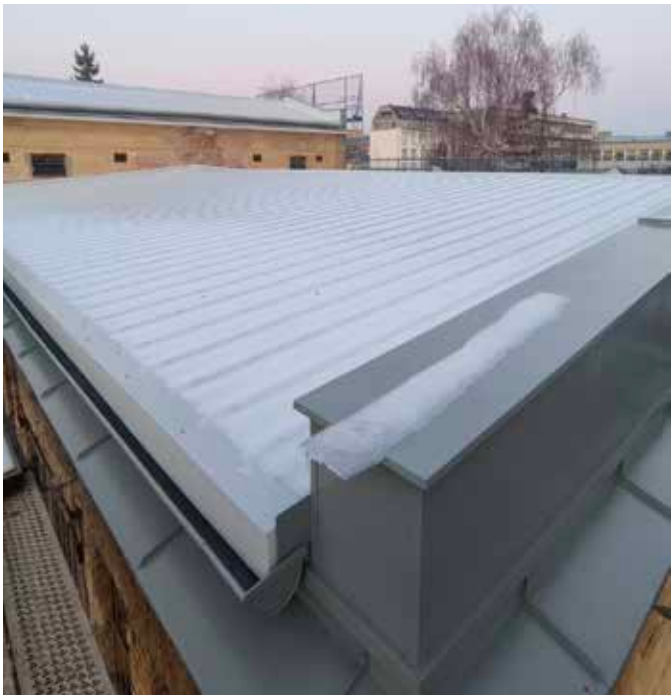
Erneuerung der Dachpaneele
