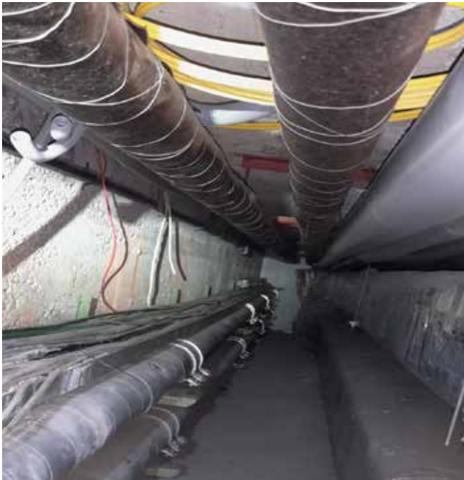
Versorgungsstollen der Kaserne
