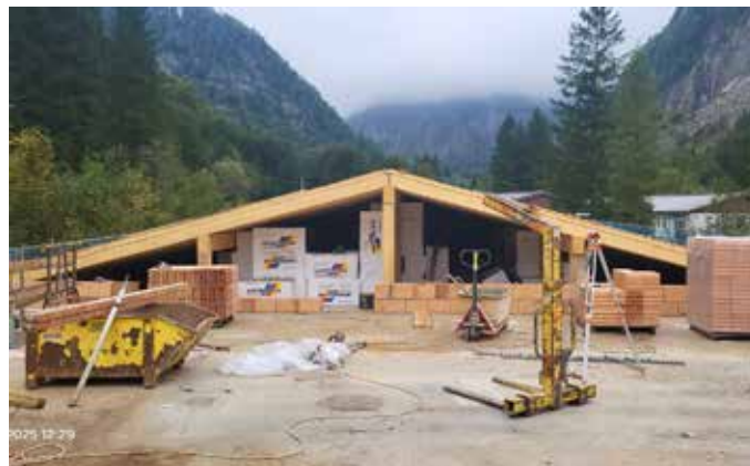
Dachstuhl neuer Bürotrakt
