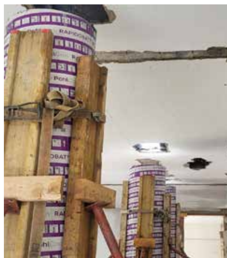
Decke Unterstellarbeiten
