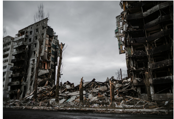
Zerstörung in Kiew nach Luftangriff
