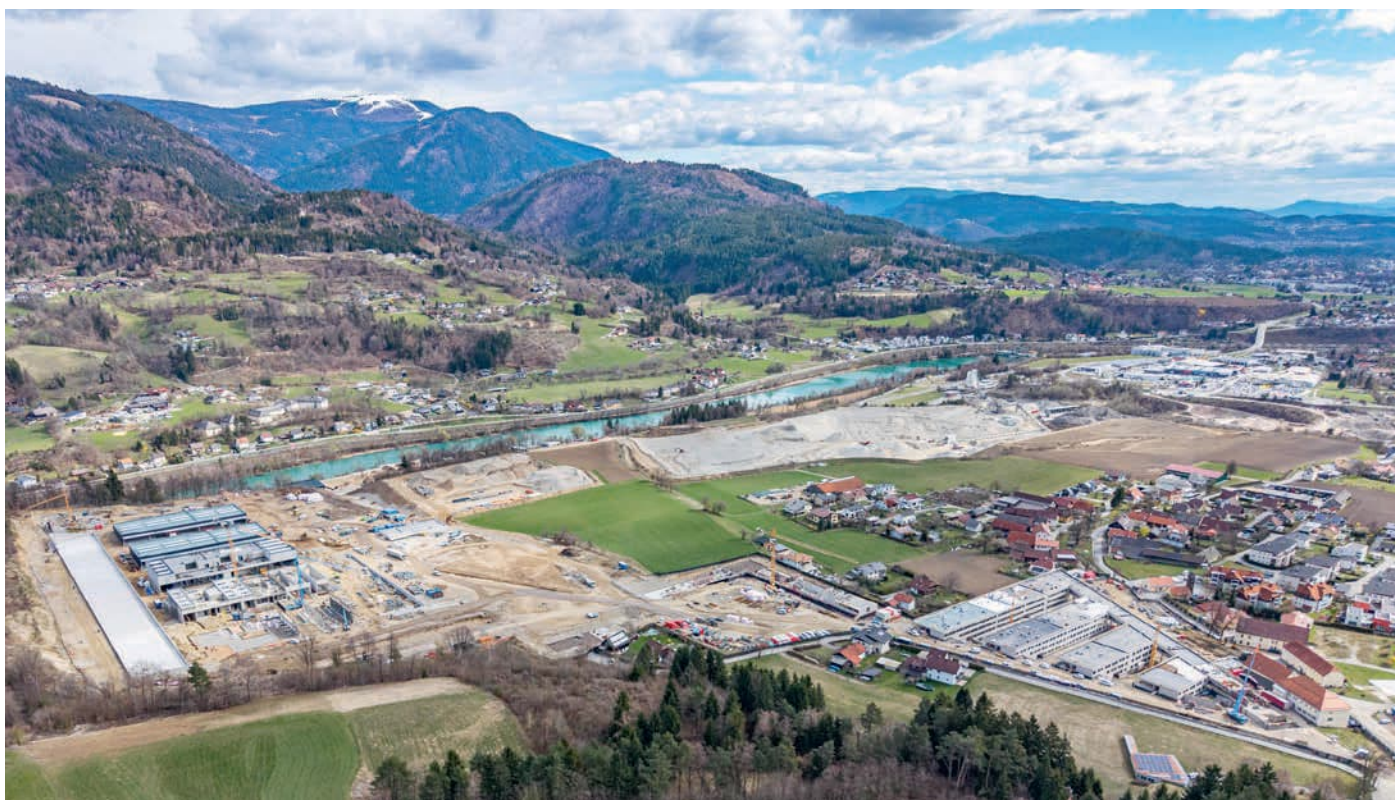
(Bild: Christoph Bauer) Drohnenaufnahme gesamtes Baufeld
