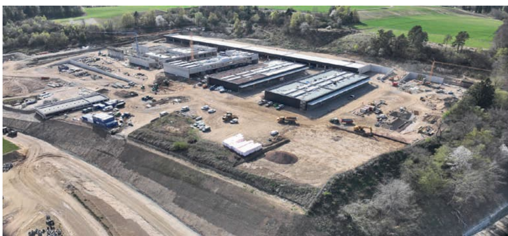
(Bild: Christoph Bauer) Aufnahme vom Werkstätten- und Garagenbezirk samt davorliegender Zufahrtsstraße
