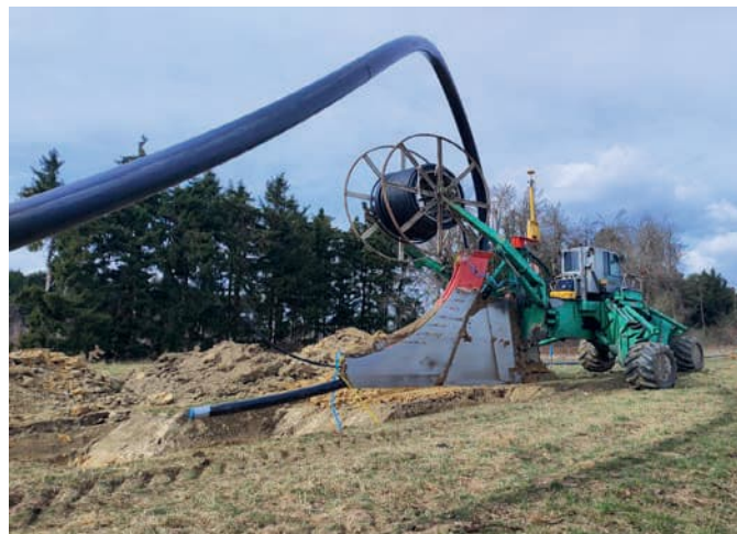
(Bild: Otto LEDITZKY) Pflugverlegung
